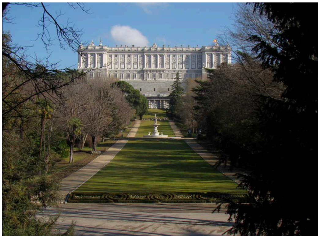
Fig. 9. Fachada oeste del Palacio Real Nuevo hacia el Campo del Moro.
