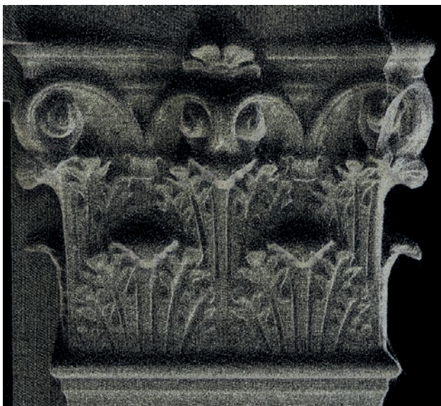
Fig. 4. Dettaglio da nuvola di punti di una parasta corinzia della Sagrestia, nonostante l'elevato dettaglio, a causa di oggetti e zone d'ombra non è possibile comprendere facilmente tutti i contorni che descrivono l'architettura.
