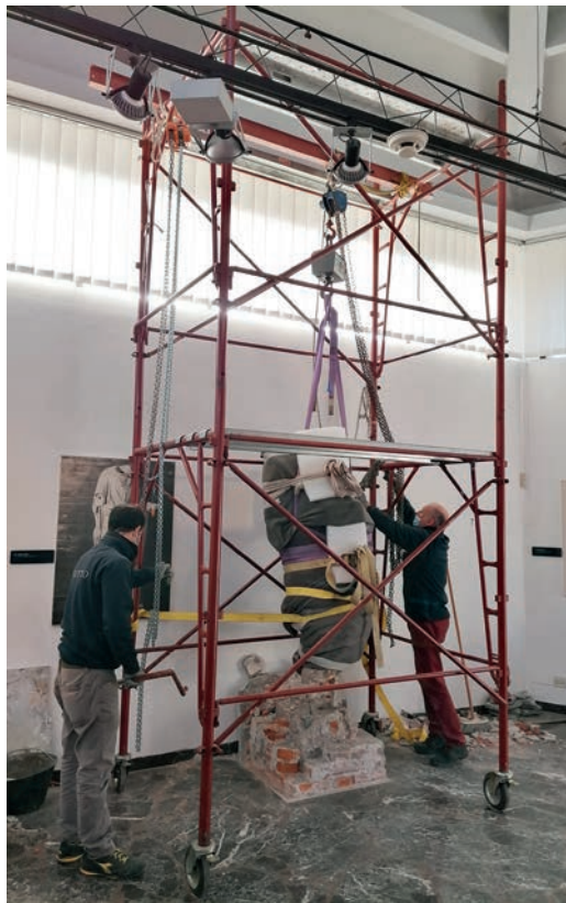
Fig. 8. Fase di movimentazione delle statue dopo la parziale demolizione dei piedistalli.
