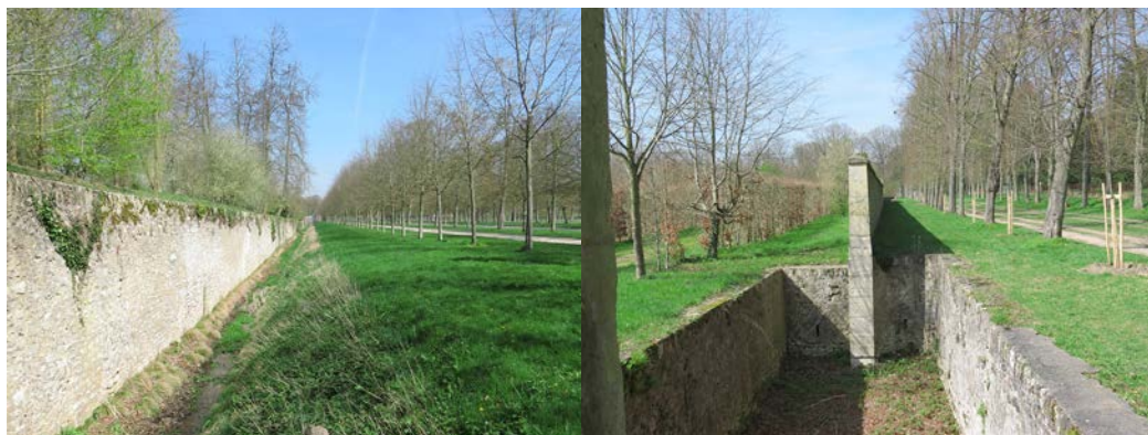
Fig. 7. Il parco del Petit Trianon di Versailles, il dispositivo Ah-Ah impiegato in soluzione di continuità con il muro di confine lungo limite settentrionale, vista (Foto D. Crispino, 2017).
