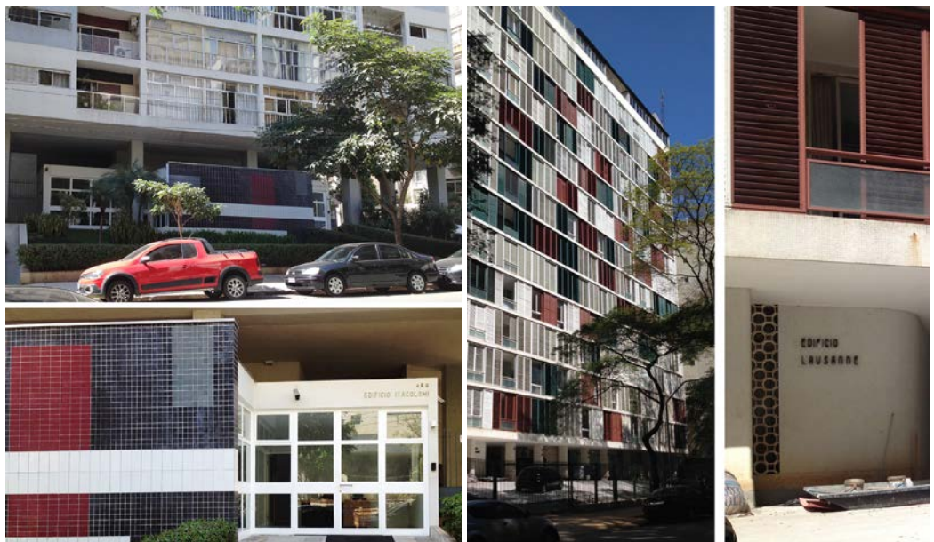
Fig. 3. Edificio Itacolomi, 1961, di V. Reif architetto che negli anni '30 ha collaborato con Taut nel Bauhaus (foto degli autori, 2017).
