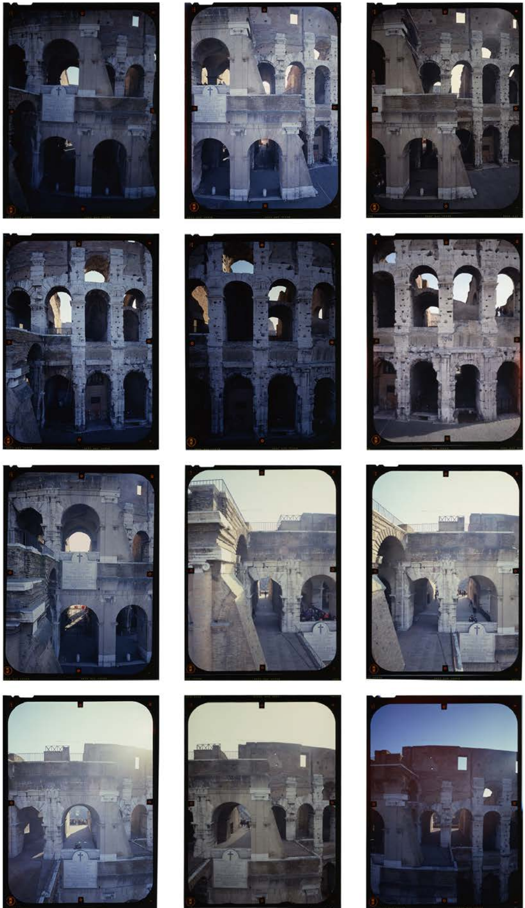
Fig. 1. Rilievo del Colosseo, 2000. Positivi su pellicola 5x7 pollici scattati con camera metrica Zeiss UMK 1318, acquisiti con scanner Epson Perfection V700 a 6400 dpi.
