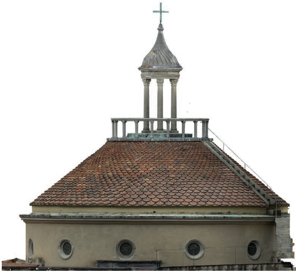
Fig. 8. Fotopiano dell'esterno della cupola della Sagrestia, dove è possibile vedere la singolare struttura con cupola di gusto arabeggiante posizionata sulla sommità (restauro di Sanpaolesi).
