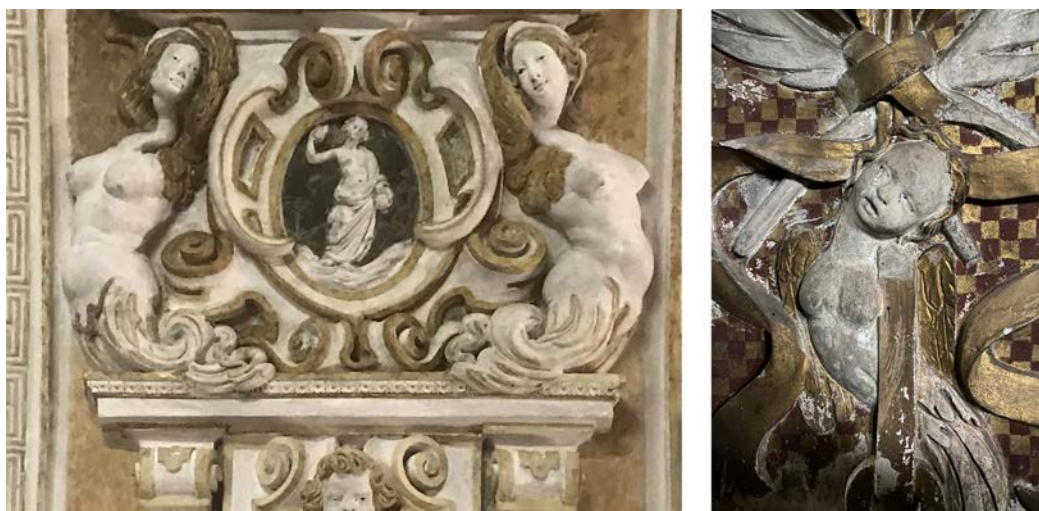
Fig. 7. Confronto fra il modellato dei Colomba, a destra: particolare della decorazione firmata da Giovan Antonio Colomba e dal figlio Andrea; a sinistra: un particolare decorativo in stucco della volta della Chiesa di Santa Maria del Corlo in Lonato (BS). È evidente, in entrambe le soluzioni decorative, la deformazione del collo delle figure femminili.
