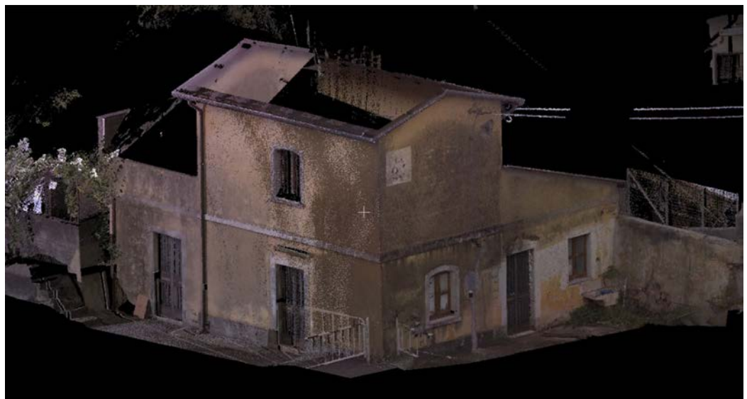
Fig. 12. La nuvola di punti del casello 92 ottenuta mediante rilievo laser scanner.
