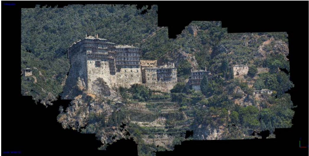
Fig. 10. Il Monastero di Simonpetra. Nuvola dei punti realizzata dal mare.
