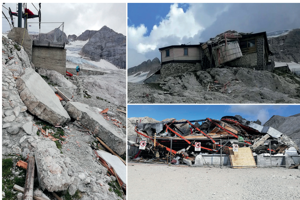
Fig. 03. Il rifugio distrutto (foto dell'autore).
