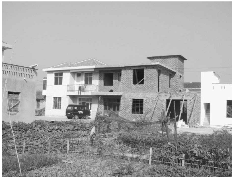
Illustration 4. Une maison de déplacés à Chongming (Shanghai) avec une extension en cours de réalisation
