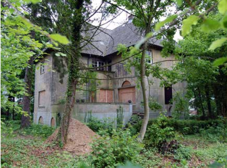
Abb. 26: Dehmelhaus, Zustand vor Restaurierung (2014)
