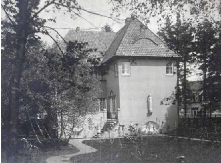
Abb. 4: Dehmelhaus von Süden (um 1912)
