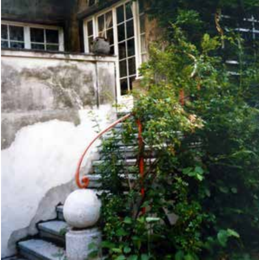
Abb. 47: Erste Sanierungsmaßnahmen (1980er-Jahre)
