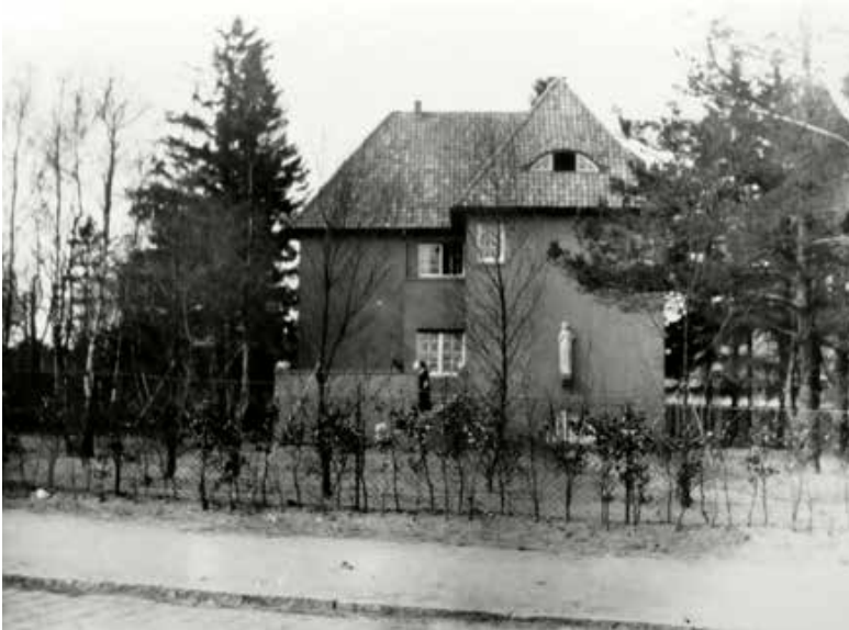
Abb. 7: Dehmelhaus von Süden (um 1912)
