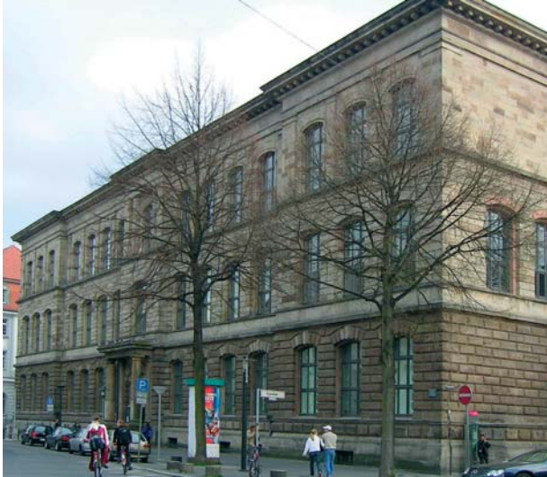
Prinzenstraßentrakt des Historischen Gebäudes der SUB Göttingen
