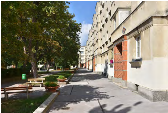
82. KARL SEITZ-HOF, CHEMIN RELIAIT LES ACCÈS DANS LA COUR DE LA DEUXIÈME PHASE DE CONSTRUCTION.
