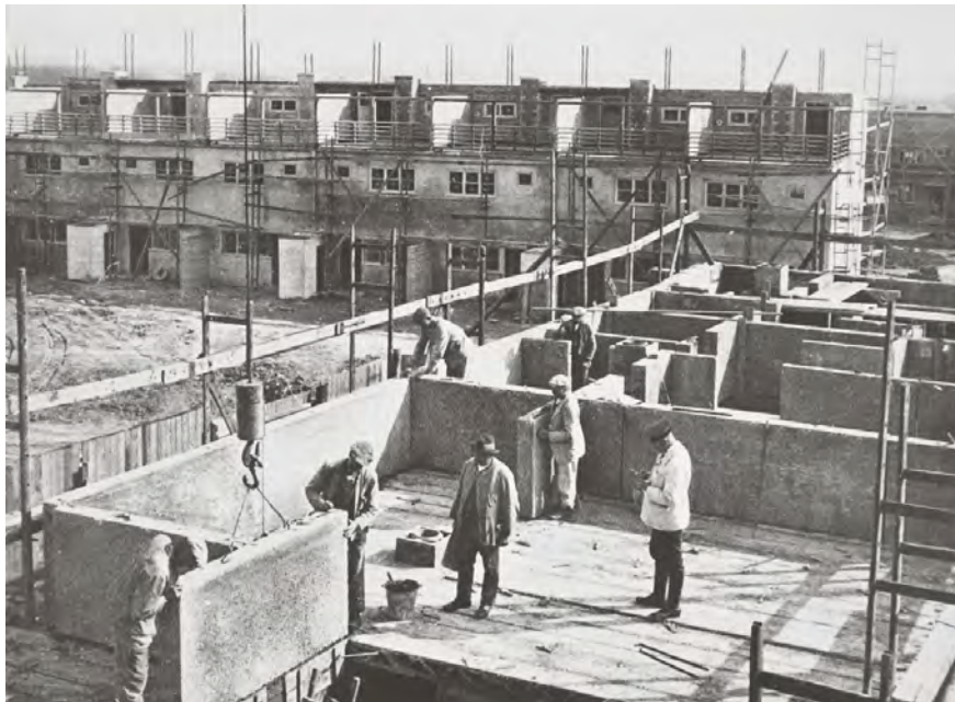
43. SIEDLUNG PRAUNHEIM, CHANTIER DES MAISONS RÉALISÉES AVEC PANNEAUX PRÉFABRIQUÉS.
