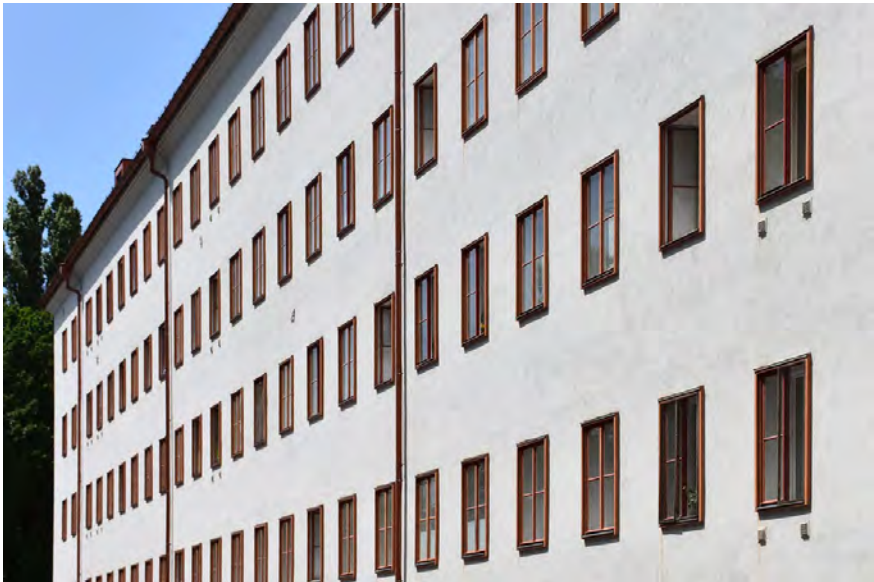
58. KLOSE-HOF, FAÇADE HOMOGÈNE SUR FICKERTGASSE.
