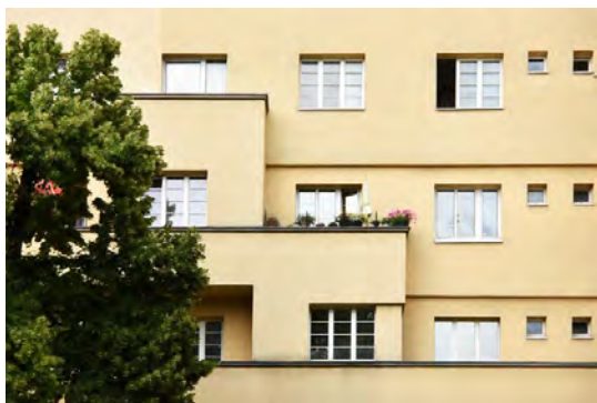
52. BEBEL-HOF, BOW-WINDOW ET TERRASSE À L'INTÉRIEUR DE LA COUR.
