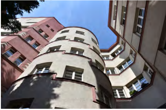
55. SCHÜTTAU-HOF, DÉTAIL D'ANGLE À L'INTÉRIEUR DE LA COUR.
