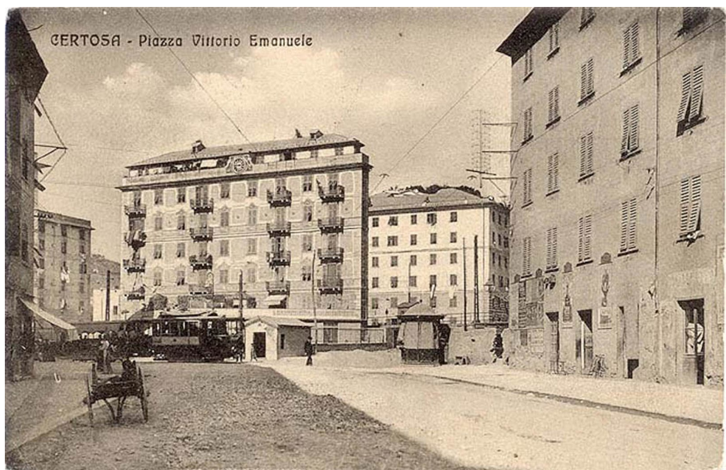
Fig. 1. Immagine storica della zona pre-Ponte Morandi.
