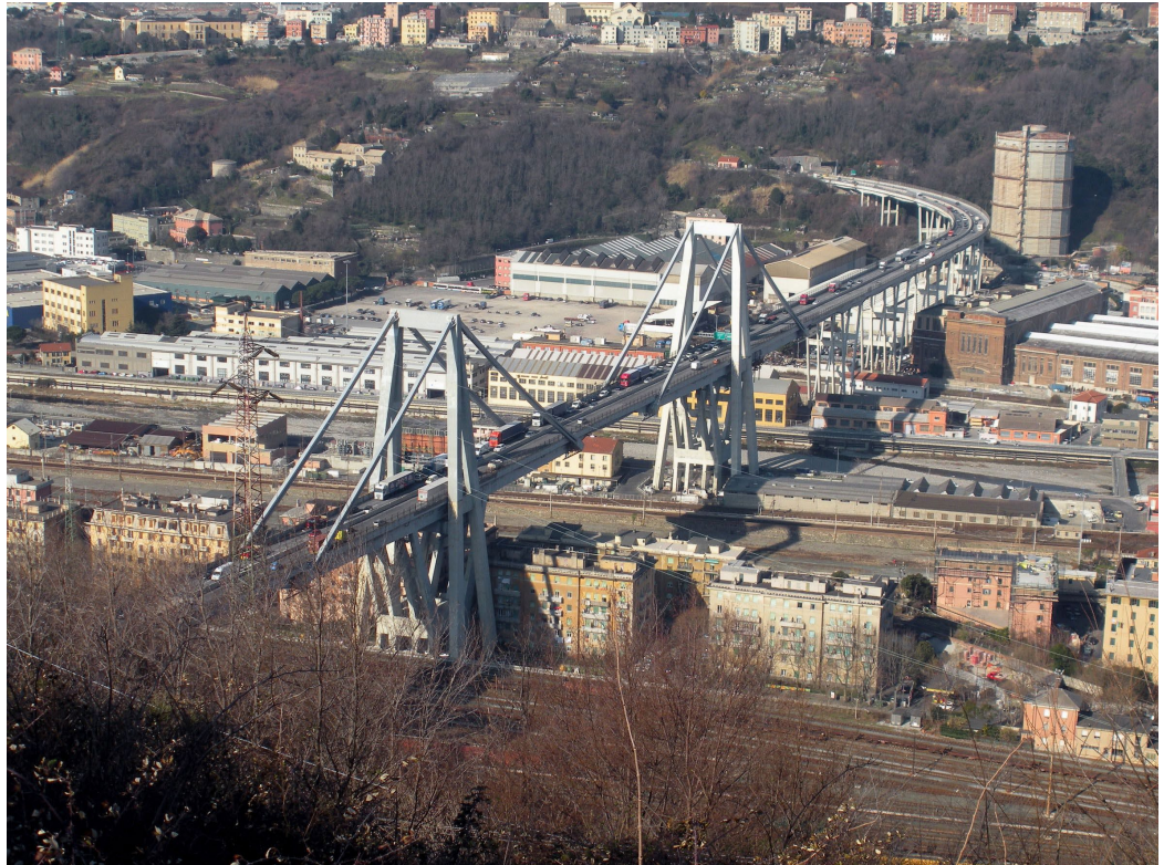
Fig. 2. Immagine del Ponte Morandi all'interno del tessuto urbano.
