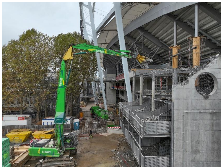
Abb. 4: Teilabbruch Tribüne mit Unterfangung (Bild: Arnim Kilgus)
