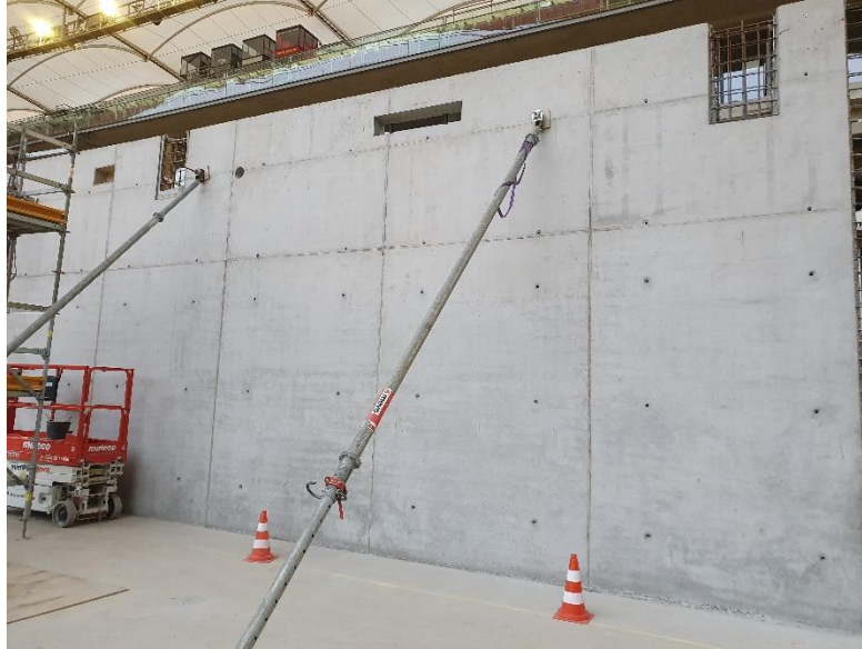
Abb. 8: Neuaufbau Haupttribüne mit Wand aus RC-Beton (Bild: Ed. Züblin AG)
