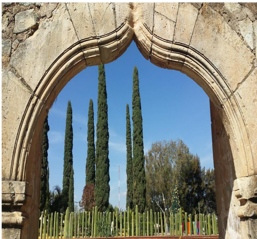
Ventanas en la única pared en pie de la casa de Cortés en Cuilapam, Valles Centrales, Oaxaca, México. Foto: Berenice Pardo
