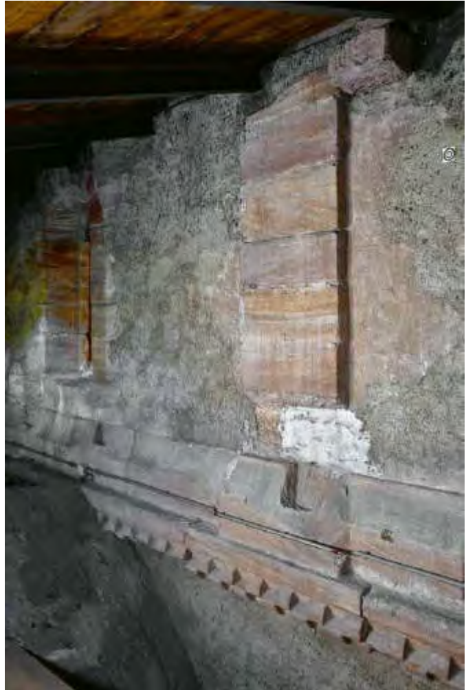
ABB. 97 Dachraum über dem nördlichen äusseren Seitenschiff. Über den Gewölben der äusseren Seitenschiffe ist die spätromanische Gliederung der Seitenschiffwand noch sichtbar: Oberhalb des Zahnschnitts folgt ein Gesims, von dem zwischen den Fenstern Lisenen aufsteigen. Hier, über der Mainzerkapelle, ist in das Gesims in regelmässigen Abständen eine rechteckige Nut eingehauen, die wohl von einer provisorischen Balkendecke der Kapelle zeugt. Foto Peter Schulthess, 2018. DpfBS.
