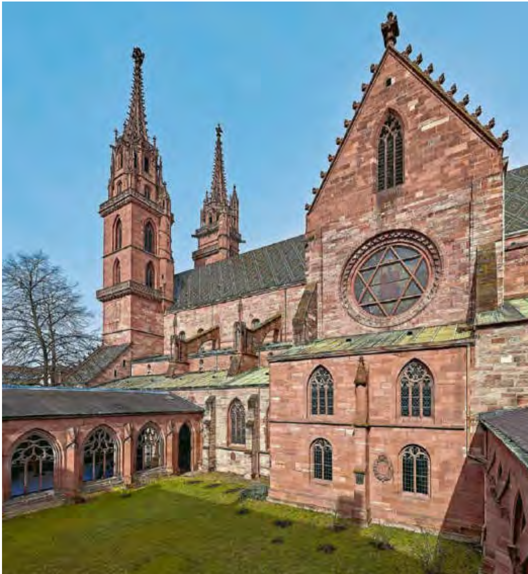
ABB. 196 Südquerhausfassade. Das die Fassade beherrschende grosse Rundfenster hat eine Verstrebung in Form eines Sechsecksterns. Das Hexagramm hatte im Mittelalter verschiedene Bedeutungen, symbolisierte aber nicht den Davidstern. Foto Peter Schulthess, 2018. DpfBS.
