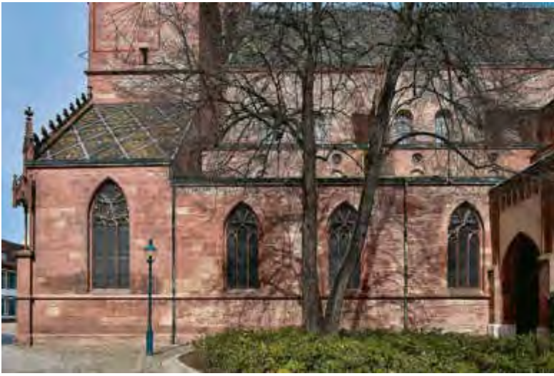
ABB. 95 Südliches Seitenschiff, nach 1300. Die Außenmauer zeigt ein über die ersten drei Kapellen durchgehendes Fugenbild. Nur im Sockelbereich erfolgt zwischen der Bebelnheim- und der Tegernaukapelle in den ersten vier Quaderschichten ein Lagenwechsel. Foto Peter Schultness, 2018. DpfBS.
