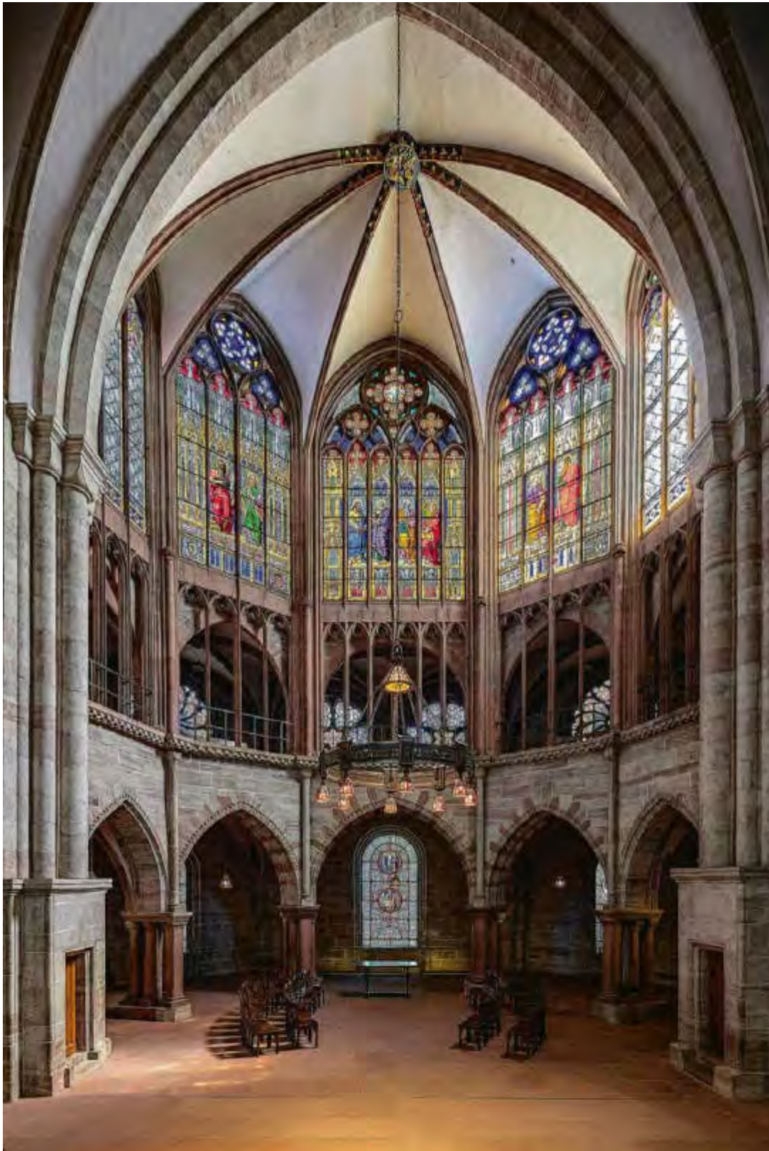
ABB. 207 Chorpolygon. Die von Bündelpfeiler getragenen Arkaden werden zur Mitte hin breiter. Sie gehören noch zum spätromanischen Bestand, während darüber im Emporengeschoss beim Wiederaufbau nach dem Erdbeben von 1356 in raffinierter Weise der Übergang zum lichtdurchfluteten Obergaden geschaffen wurde. Foto Peter Schulthess, 2018. DpfBS.
