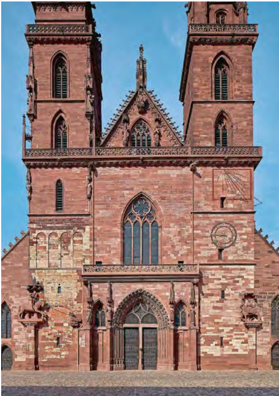
ABB. 90 Westfassade. Mit Ausnahme der unteren beiden Geschosse des Georgsturms stammt der Hauptteil der Fassade mit dem grossen Westfenster, dem Portalblock sowie den mit der Mittelschiffassade im Verband gemauerten ersten drei Geschossen des Martinsturms aus der gotischen Erneuerung des späten 13. Jh. Foto Peter Schulthess, 2018. DpfBS.
