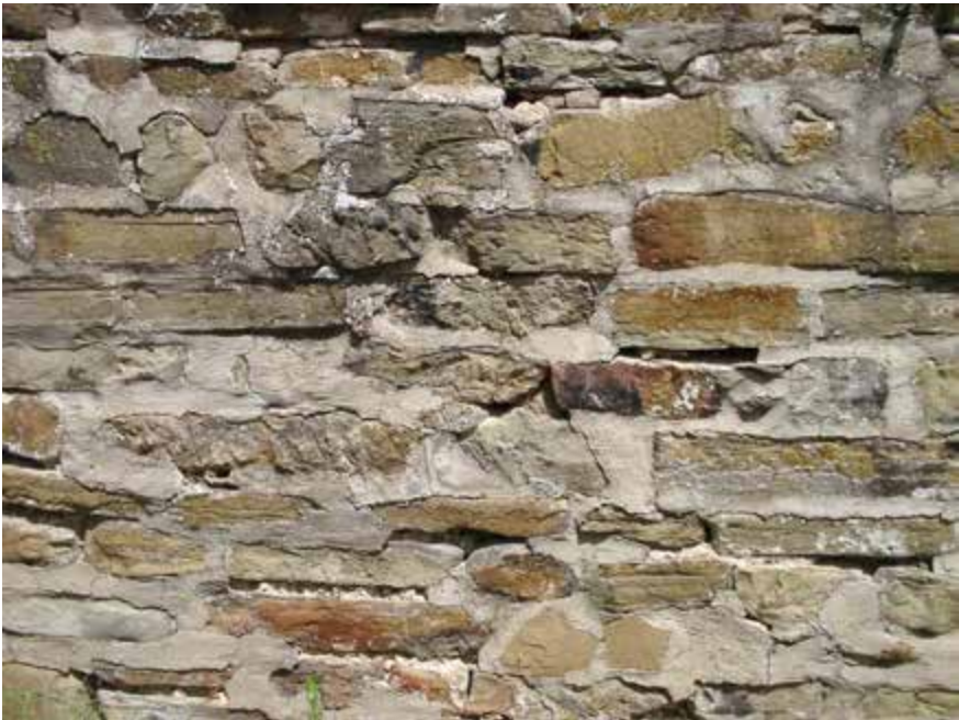
Figura 8. Madre di Dio. Dettaglio della muratura ricostruita della 'III fase' – nartrice (2005).
