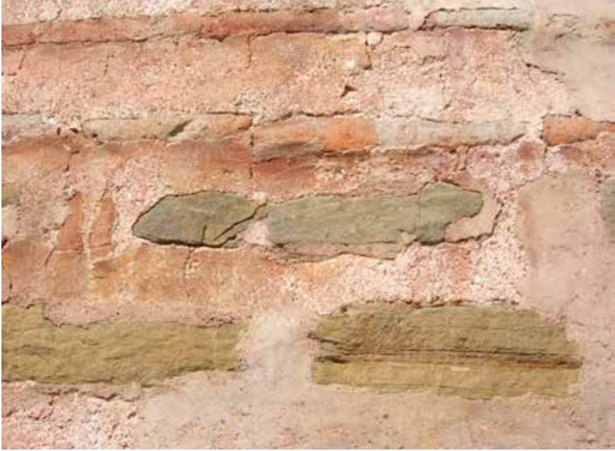
Figura 22. San Nicola. Muratura della 'II fase'. Dettaglio del muro sud della torre (2005)
