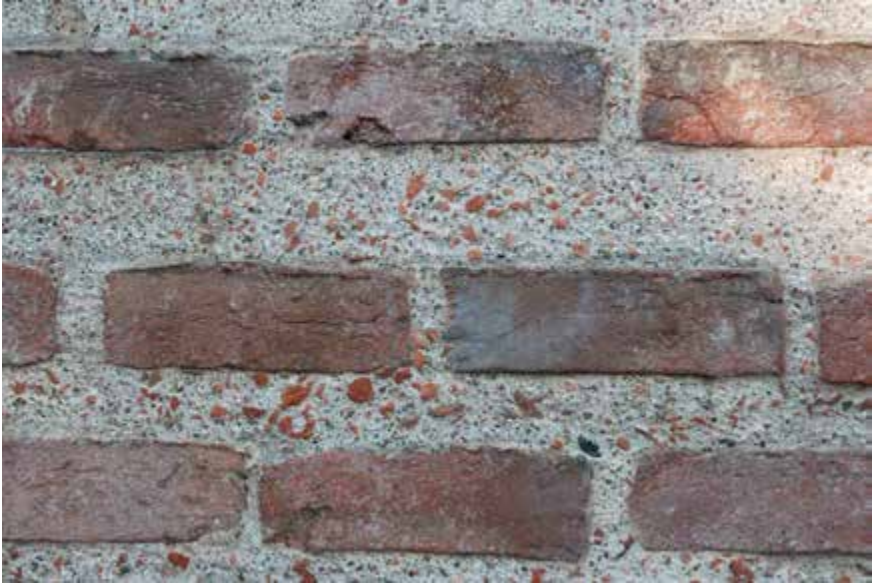
Figura 11. Madre di Dio. Dettaglio della muratura ricostruita della 'I fase' (2007)
