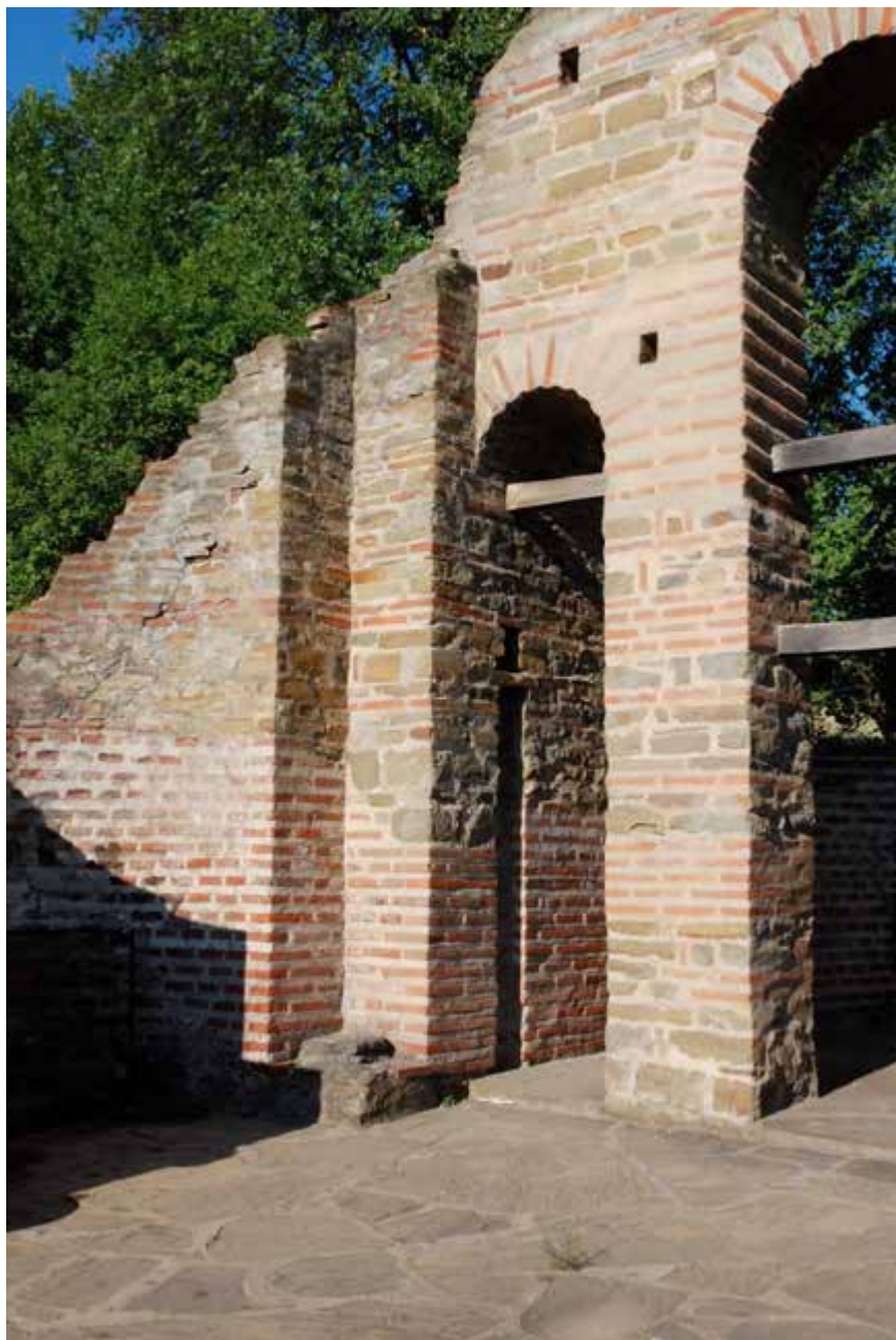
Figura 16. Madre di Dio. Dettaglio della muratura ricostruita della 'II fase' – templon (2005)
