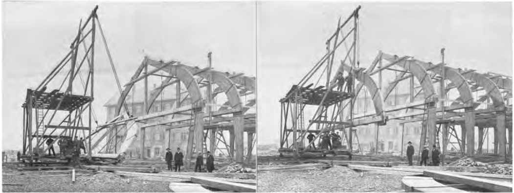
Figure 1. Construction process of the girders of the Schweizerische Eternit-Werke in Niederurnen, ca. 1912 (Schw. AG für Hetzer'sche Holz1913).
