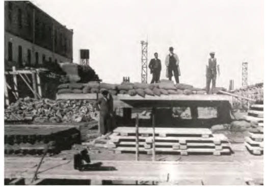
Figure 5. Reinforced concrete structure of the polygonal skylight in the roof of an operating theatre. Ingeniería y Construcción 127, July 1933. Archivo Torroja, CEHOPU-CEDEX, I-ETM-095-02.
