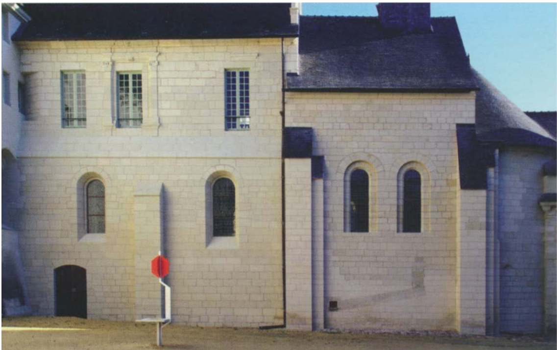
Figure II-1: Mur sud de la chapelle Saint-Benoît de Fontevraud, Maine-et-Loire. L'ensemble de la paroi a été homogénéisé par les restaurations alors que le bas de la nef (gauche) date du début du XII e , le chœur de la fin, l'étage de la moitié du XVI e et certaines baies ont été reprises ou créées aux XVIII e -XIX e siècles (d'après Prigent 2014).
