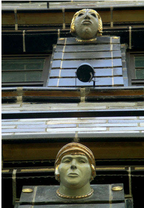
Abb. 17 Warenhaus Wertheim, Detail der Fassadendekoration von 1929
