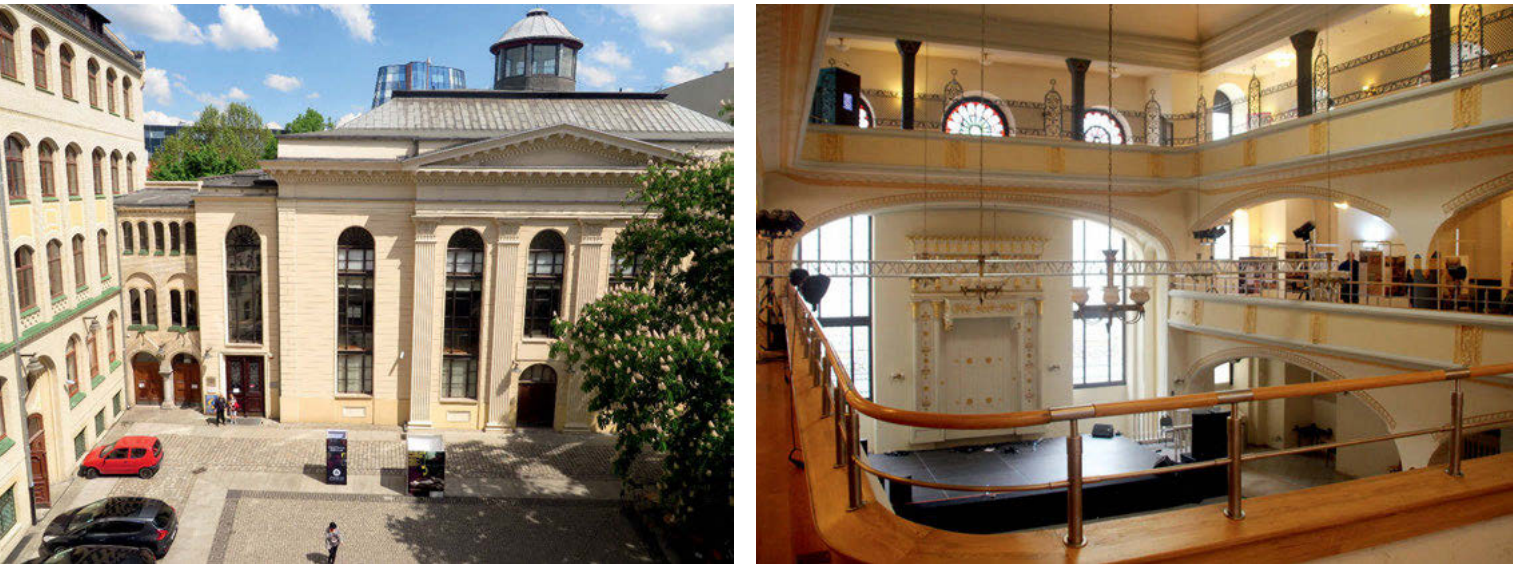
Abb. 10 und 11 Die Synagoge „Zum Weißen Storch“ in ihrem heutigen Zustand (Innenhof und Innenansicht)
