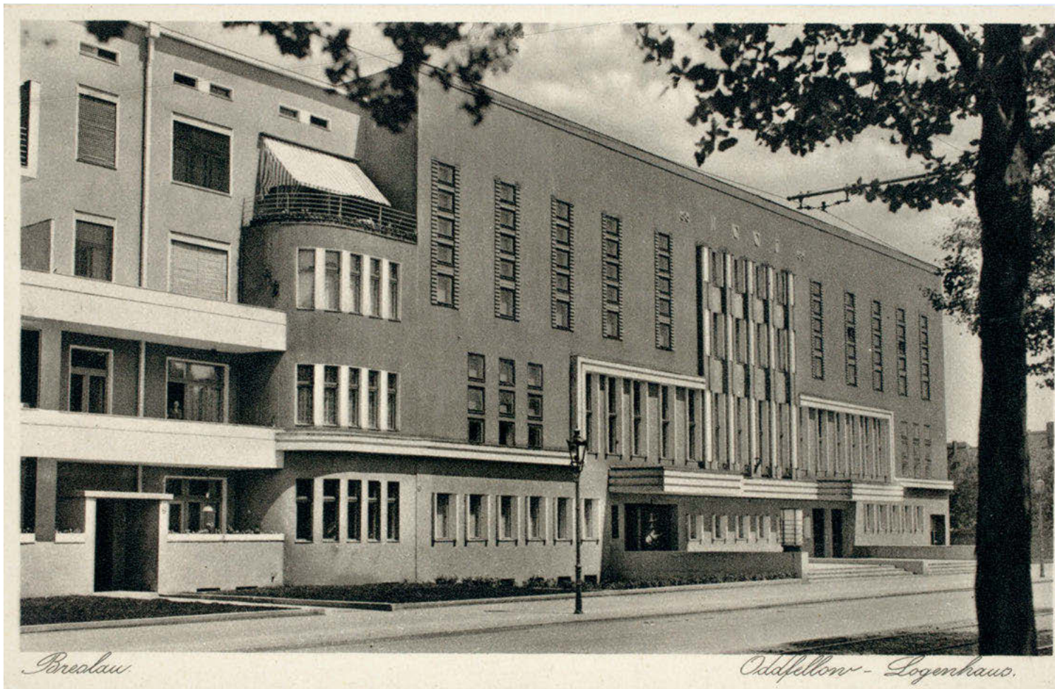
Abb. 10 Fassade der Odd-Fellow-Loge, ab 1938 Roxy-Kino
