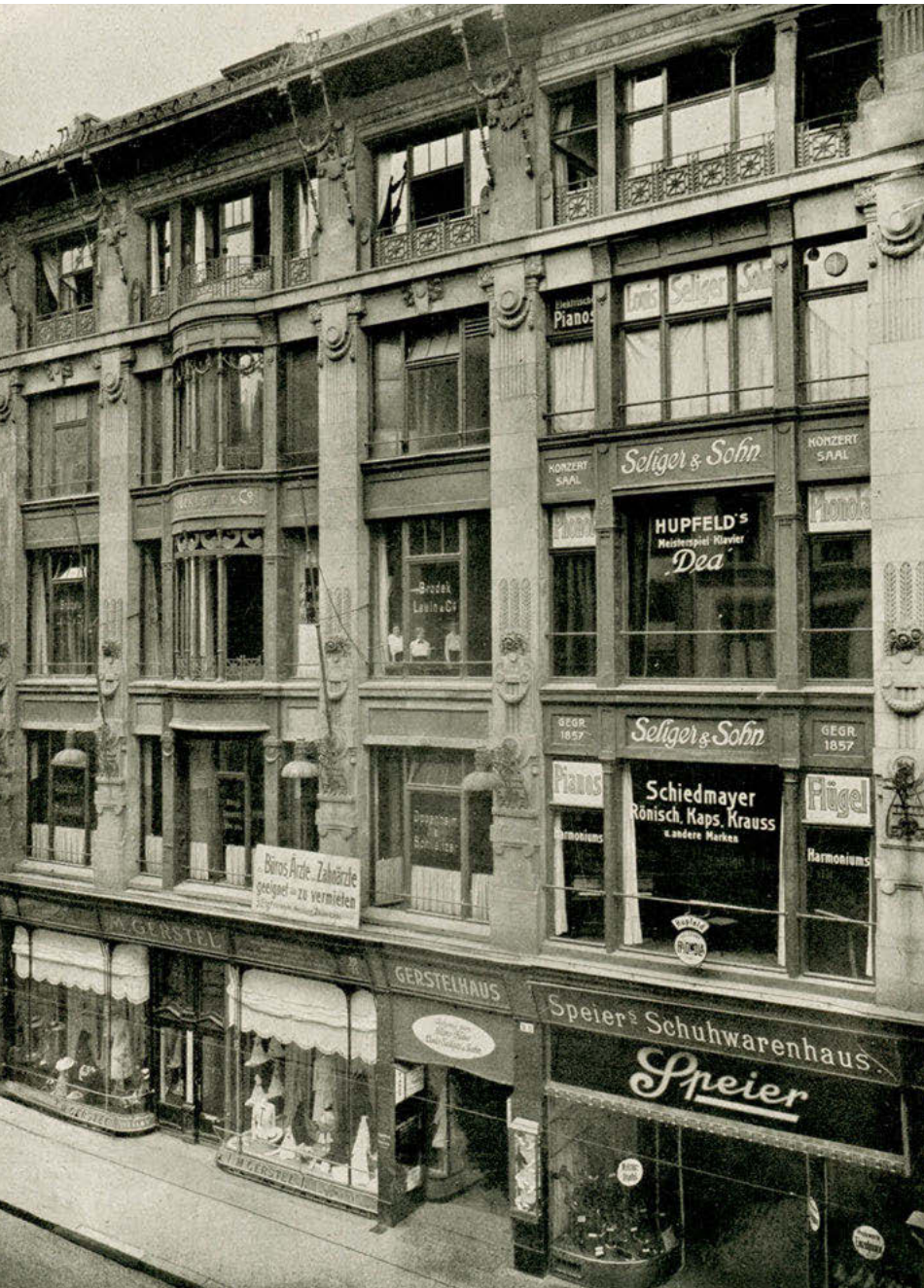
Abb. 5 Geschäftshaus M. Gerstel an der Schweidnitzer Straße 10/11, 1903, Ausbau 1910
